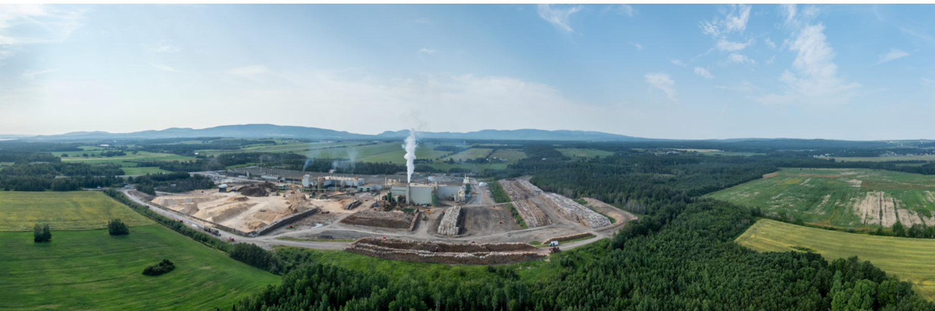
Vue aérienne de l'usine de panneaux de particules (OSB) et de mélanine qu'exploite Uniboard à Sayabec dans la vallée de la Matapédia.
